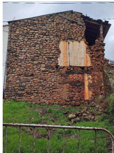
3. Fachada lateral direita
